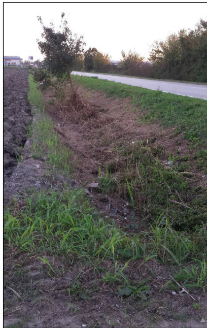
Vista dell'affossatura lato Est SP17 in prossimità dell'immissione nello scolo consortile Canda
