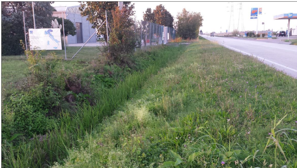
Figura 7 – Vista affossatura lato Ovest SP17
